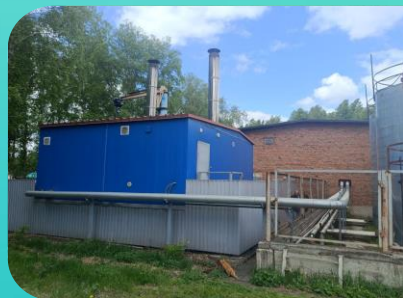
Установка блочно- модульной котельной (МКПР)
