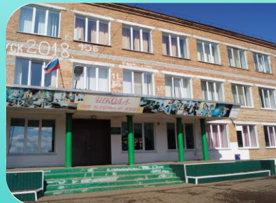
Капитальный ремонт школы (МКПР)
